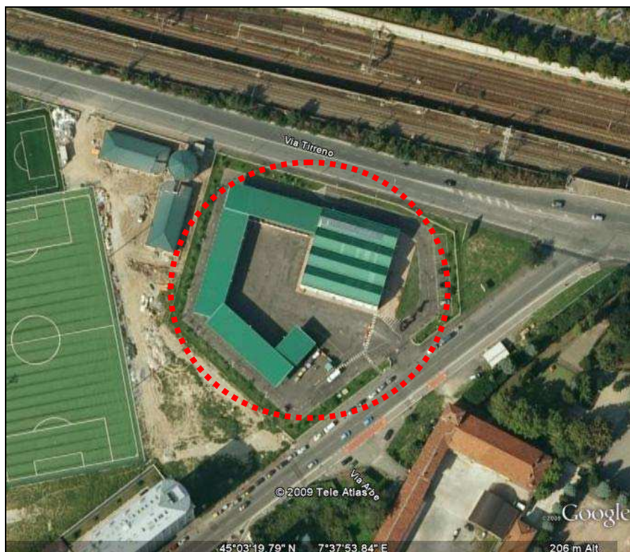
Inquadramento da satellite dell'area in cui ricade l'ecocentro di via Arbe (evidenziata con ellisse rossa)
